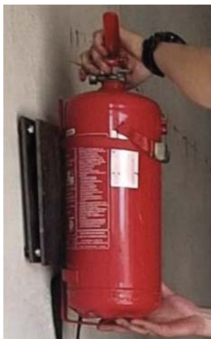
Fot. 4. Chwyt gaśnicy podczas kontroli z zastosowaniem wieszaka obrotowego
