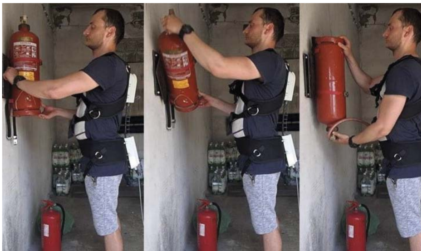
Fot. 2. Inspekcja gaśnicy wykonywana z użyciem wieszaka obrotowego
