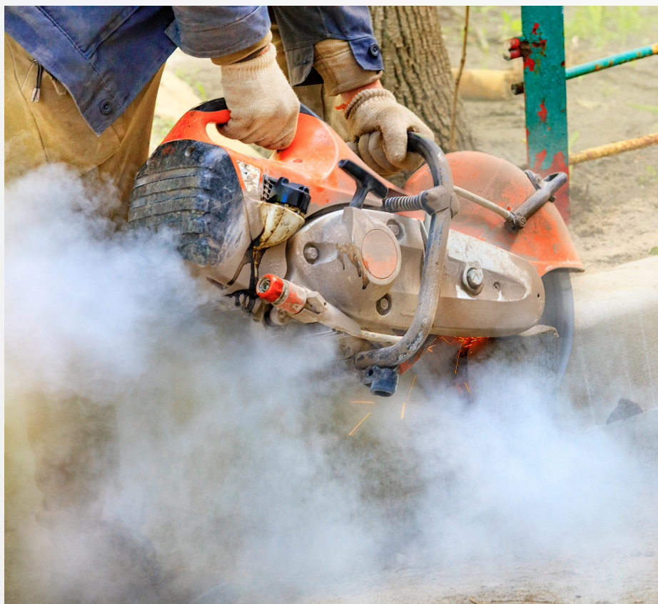
Cięcie betonu – przykład procesu, w trakcie którego może się uwalniać FRKK (fot. photosergij/Bigstockphoto)
